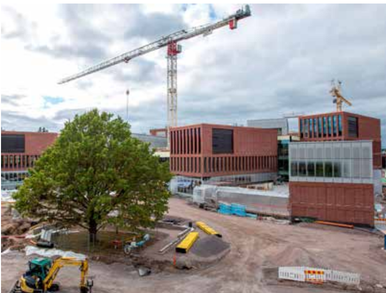
Aalto Artsin uuden päärakennuksen Väreen ja Otaniemen Metrokeskuksen työmaa
